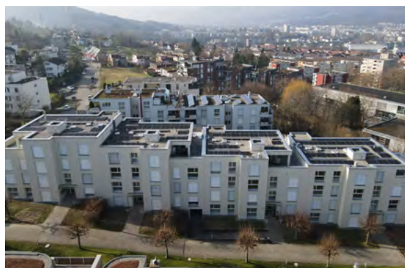
Sanierte Liegenschaft in Olten
