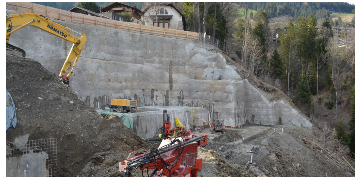
▼ Aufwendige Hangsicherung auf der Baustelle in Adelboden
