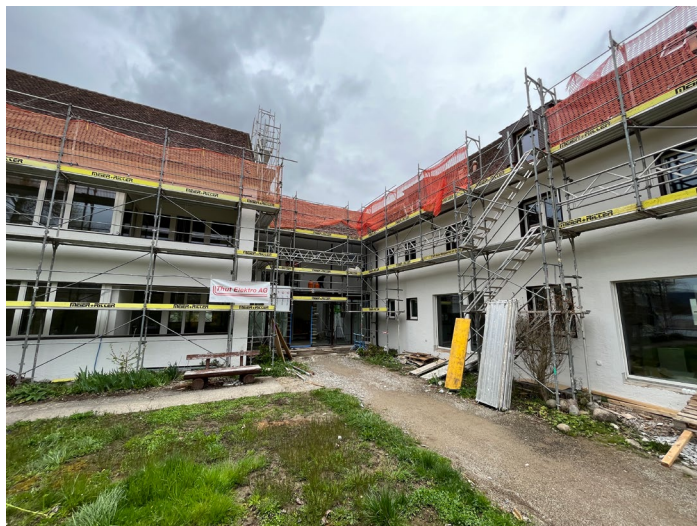
▲ Das Mehrgenerationenhaus «Fahr11» steht kurz vor der Vollendung.
